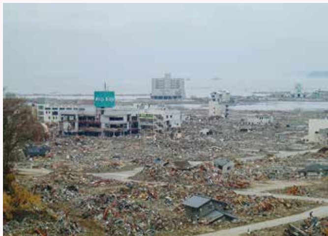
壊滅的な被害を受けた陸前高田市中心市街地
